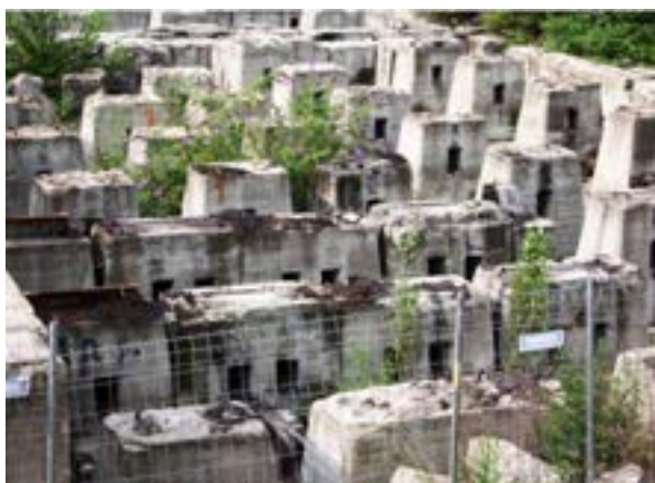
I plinti di fondazione dei laminatoi prima della rifunzionalizzazione. Fotografia Comitato Parco Dora,
